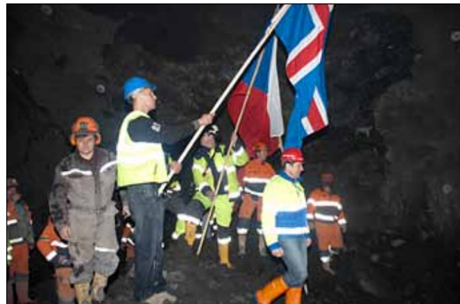
Starfsmenn við gangagröft koma í gegnum síðasa haftið sem var sprengt í Ólafsfjarðarlegg Héðinsfjarðarganga 09.04.2009.
