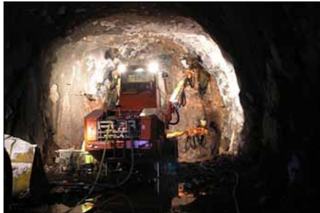
Unnið við borun í Ólafsfirði 22.11.2006.
