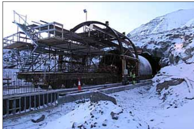
Bygging vegskála í Ólafsfirði 07.12.2009.
