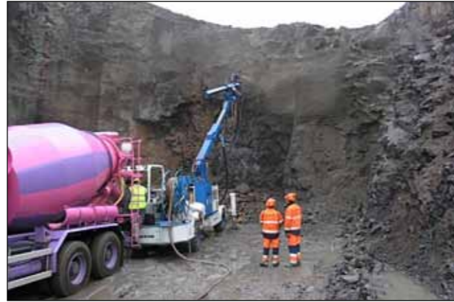
Unnið við bergstyrkingu á munnasvæði í Siglufirði 19.12.2005.
