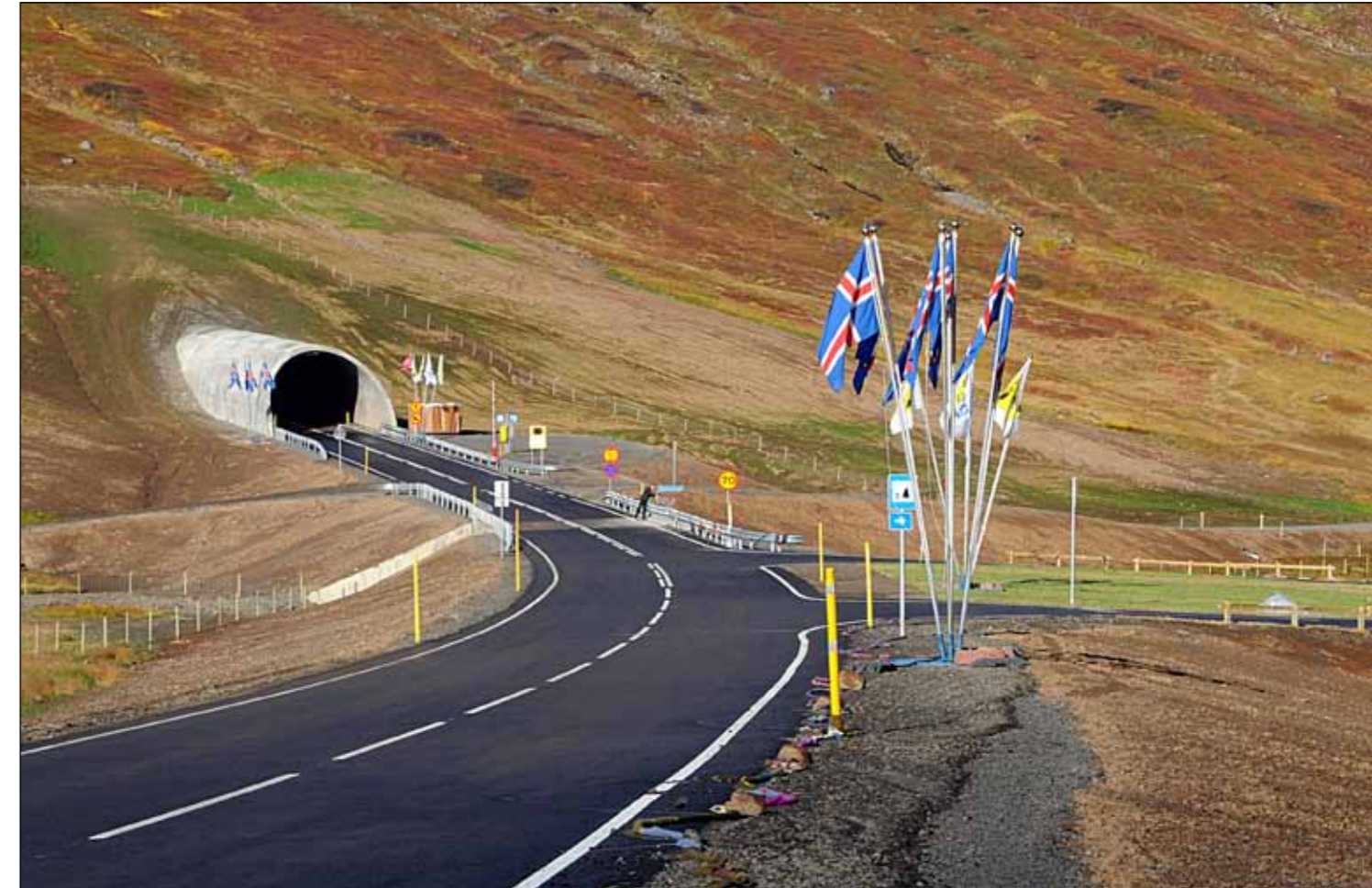
Fullbúin Héðinsfjarðargöng á vígsludegi 2. október 2010. Gangamunni Siglufjarðarleggjar í Héðinsfirði. Í vegkantinum má sjá trefilinn langa sem lagður var á milli bæjarhlutanna í Fjallabyggð þennan dag.
